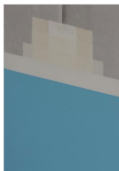
Gipskartonio plokštės paruošimas Glaistymas. Knauf Q1–Q4 paviršiaus paruošimo metodika
